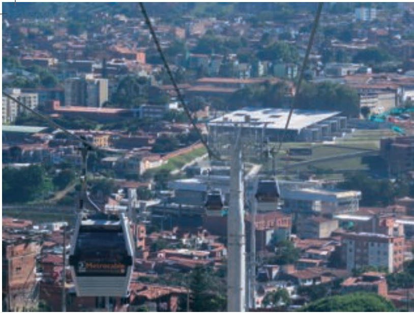
Arriba: Metrocable Nuevo Occidente . Derecha: intervención en la avenida El Poblado .
